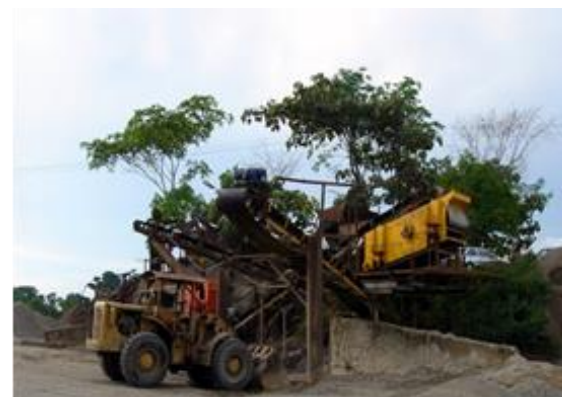
Fotografía 7-5 Acopio de materiales
