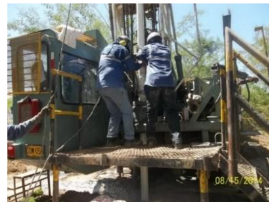
Fotografía 7-13 Perforación de un pozo de agua subterránea
