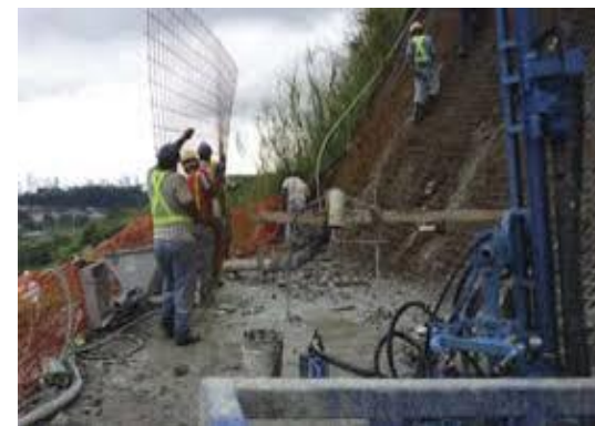
Fotografía 7-2 Estabilización de taludes
