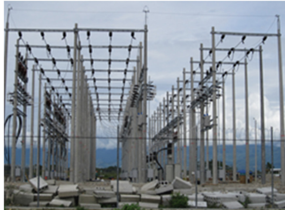
Fotografía 2.2.2-18 Montaje de Centro de Distribución – ECOPEPETROL S.A.
