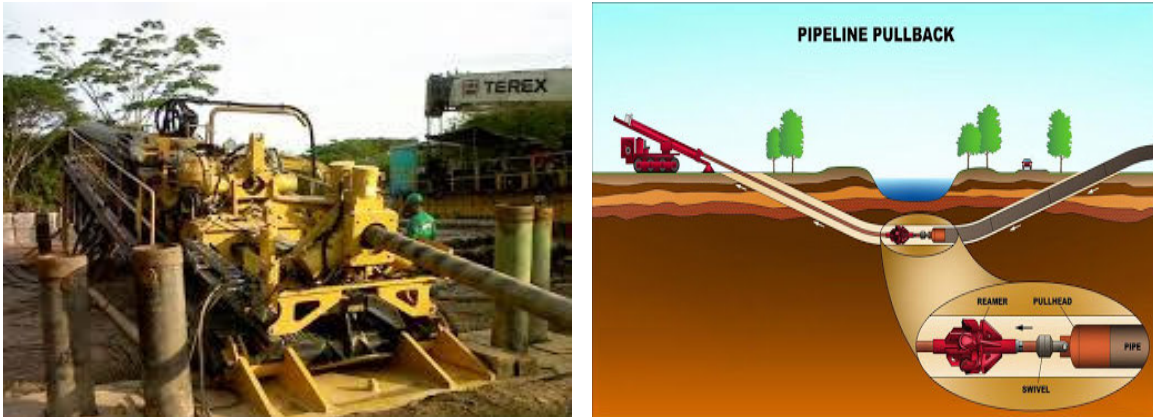
Figura 2.2.2-119 Tiro de la lingada a lo largo del túnel construido
