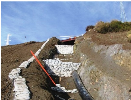
Figura 2.2.2-126 Diferentes tipos de protección con sacos de suelo cemento
