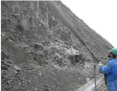
Lechada de concreto y Malla eslabonada
