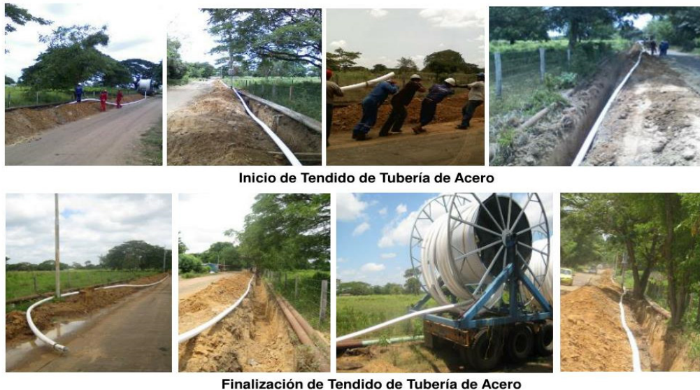
Figura 2.2.2-121 Instalación de tubería flexible
