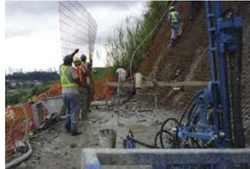
Lechada de concreto y Malla eslabonada
