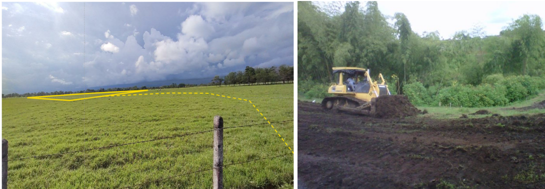
Figura 2.2.2-9 Ejemplo de área donde se proyecta la ejecución de tareas de desmonte, descapote, rocería y limpieza ya sea para construcción de una vía de acceso o una locación
