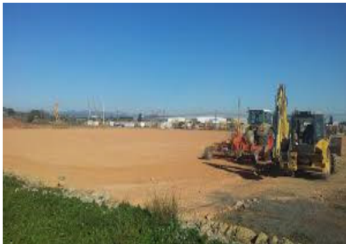
Figura 2.2.2-10 Nivelado y compactación del terreno
