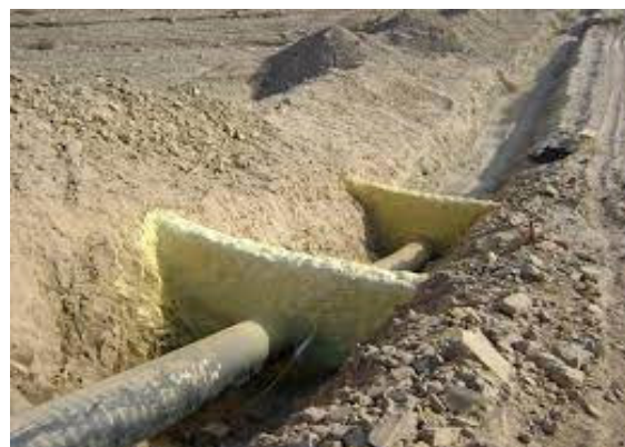
Figura 2.2.2-126 Diferentes tipos de protección con sacos de suelo cemento
