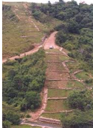
Figura 2.2.2-125 Ejemplo de obras de geotecnia al interior del derecho de vía
