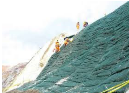
Lechada de concreto y Malla eslabonada
