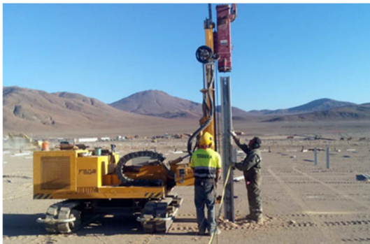
Figura 2.2.2-184 Hincado de estructuras metálicas
