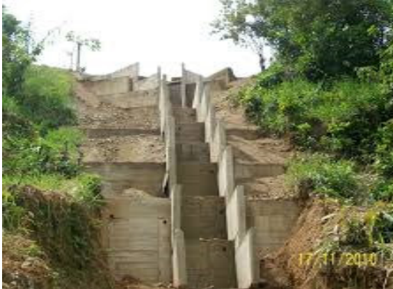
Figura 2.2.2-131 Ejemplos de descoles
