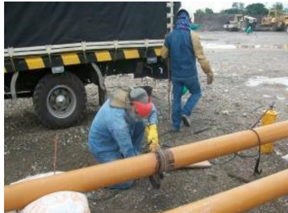
Figura 2.2.2-138 Doblado de tuberías para líneas de flujo
