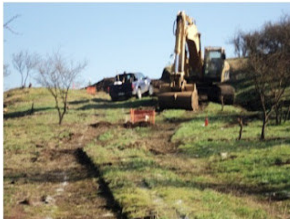
Figura 2.2.2-134 Apertura del derecho de vía
