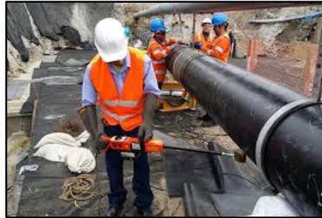
Figura 2.2.2-140 Prueba de integridad de la tubería con equipo (holliday detector)
