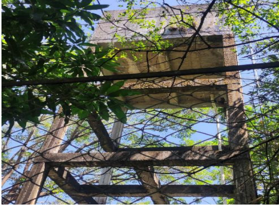
Fotografía 3.4.3-8 Tanque elevado Acueducto San Nicolás Norte
