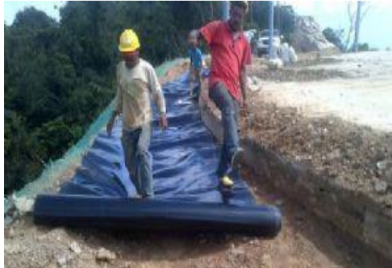
Cuneta en geotextil y/o geomembrana
