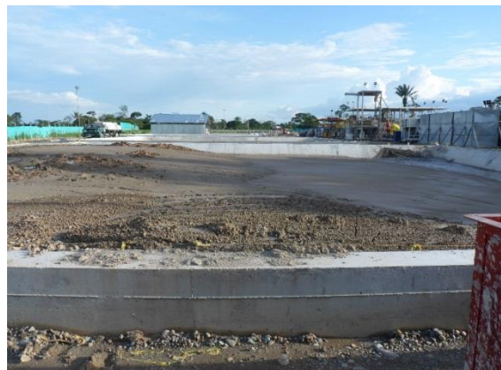
Fotografía 4.8-2 Estabilización de cortes de perforación en piscina
