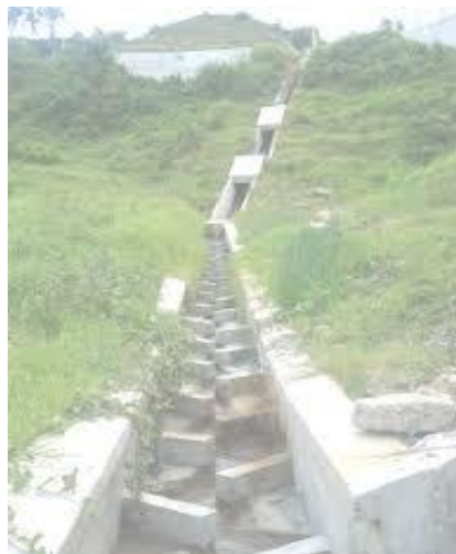
Disipador de energía
