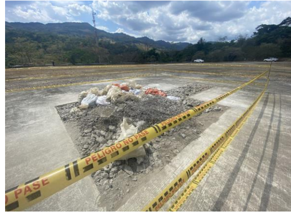
Contrapozo a adecuar
