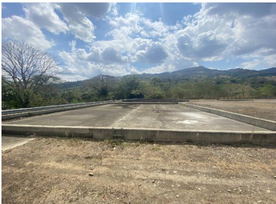
Diques en concreto
