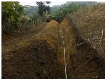
Figura 10-16 Retiro de tramos de líneas de flujo enterradas
