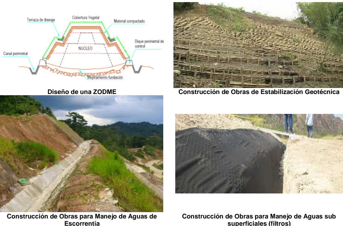
Figura 10-18 Actividades a ejecutar para el desmantelamiento de una ZODMEs
