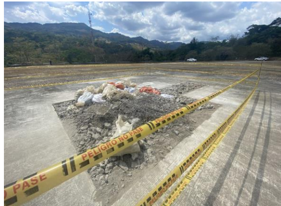
Contrapozo a adecuar
