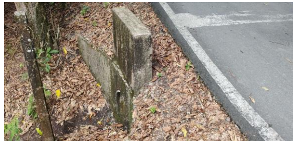
Alcantarilla sencilla \phi 12", Vía V1_1_4
