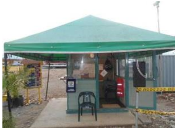
Caseta de Vigilancia
