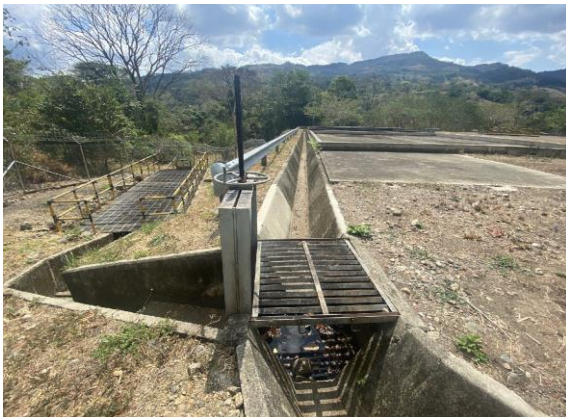
Cuneta perimetral en concreto
