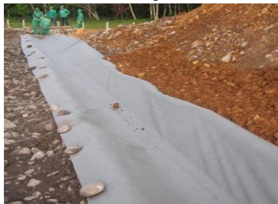
Cuneta de agua lluvia en alviodren
