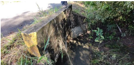
Box Culvert "Doble", Vía V1_3_1
