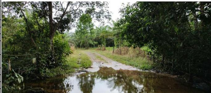
Observaciones: Esta vía presenta un ancho de calzada promedio de 5,00 m y una superficie de rodadura en afirmado en buen estado y buenas condiciones de transitabilidad, pero su integridad se ve parcialmente comprometida en épocas de lluvias por aumento del nivel del Caño Aguilinda que cubre el paso de la vía sobre el caño mencionado.
