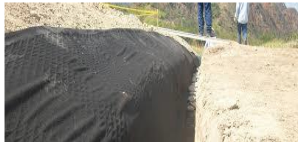
Construcción de Obras para Manejo de Aguas subterráneas (filtros)
