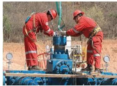
Desmantelamiento de válvulas y accesorios
