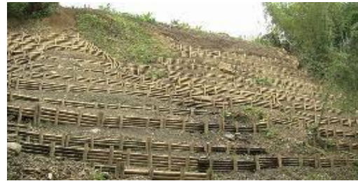
Construcción de Obras de Estabilización Geotécnica
