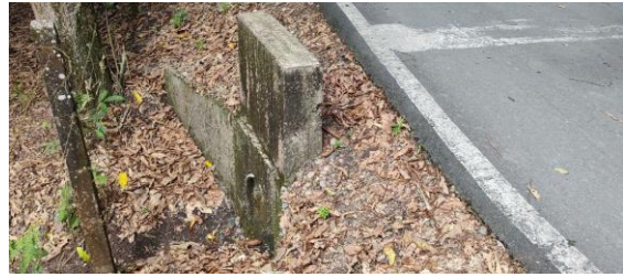
Alcantarilla sencilla \phi 12”, Vía V1_1_4
