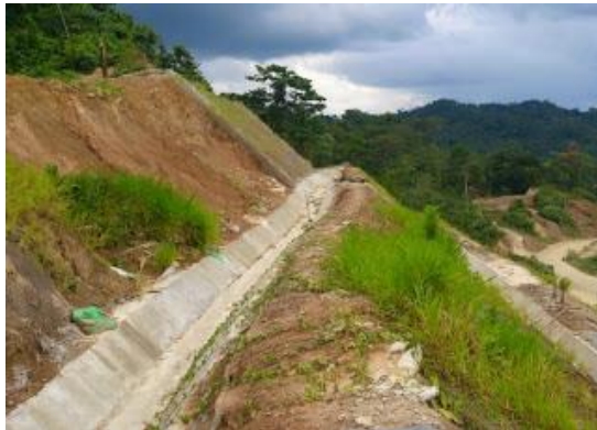
Construcción de Obras para Manejo de Aguas de Escorrentía
