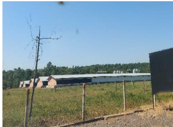
Fotografía 5.1-9 Galpón en la vereda Inspección presentado, municipio de Cumaral
