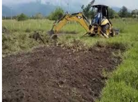
Fotografía 5.1-74 Típico de la actividad de desmonte, descapote, rocería y limpieza
