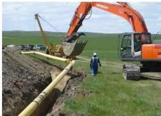
Detalle de la actividad de Apertura de zanja, instalación y tapado de la tubería
