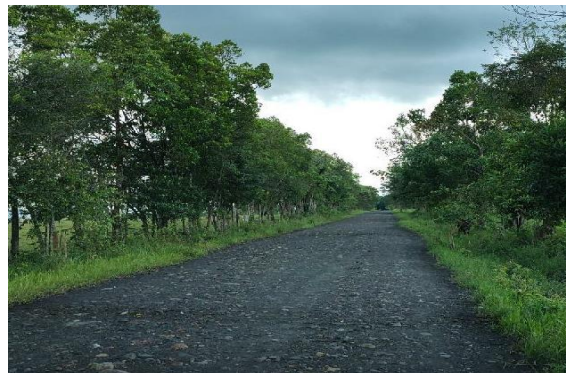
Fotografía 5.1-42 Panorámica del mantenimiento que se realiza en las vías de acceso localizadas dentro del área de influencia.
