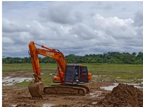
Fotografía 5.1-73 Panorámica de la actividad del movimiento de tierras realizada para la construcción de un área de locación
