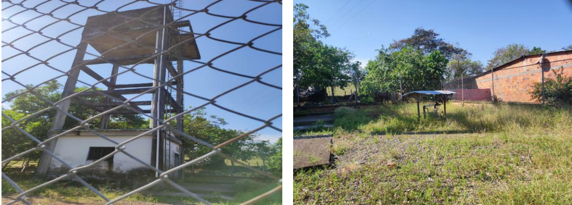
Fotografía 5.1-16 Captación acueducto Chepero
