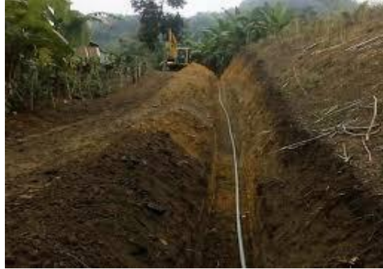
Detalle de la actividad de apertura y adecuación del derecho de vía
