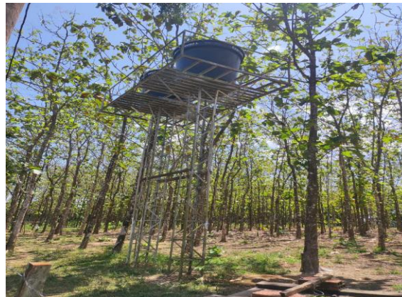
Fotografía 5.1-17 Tanques elevados (Finca El Persogo)
