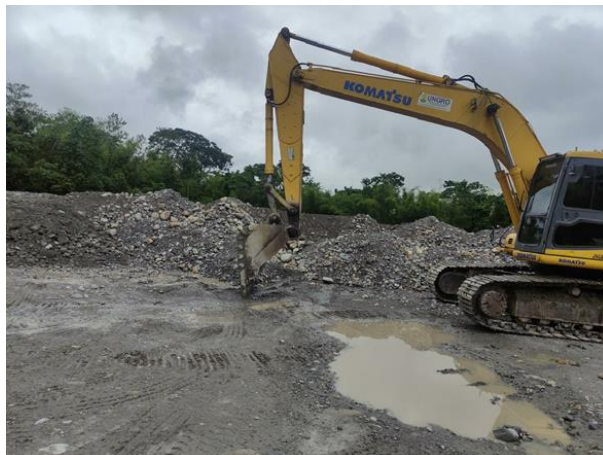
Fotografía 5.1-30 Típico de la actividad de aprovechamiento de material de arrastre
