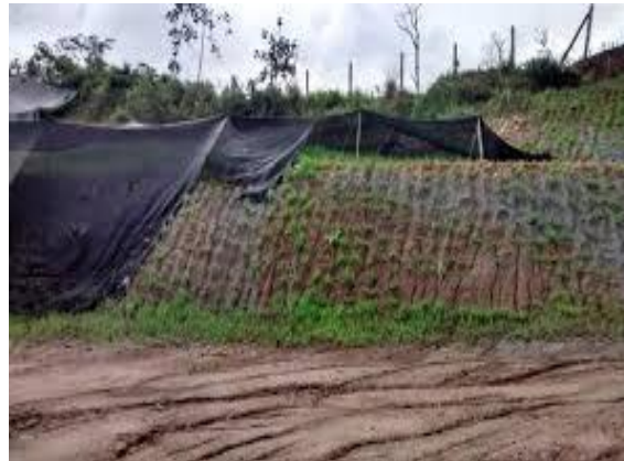
Típico de las medidas de protección superficial y revegetalización
